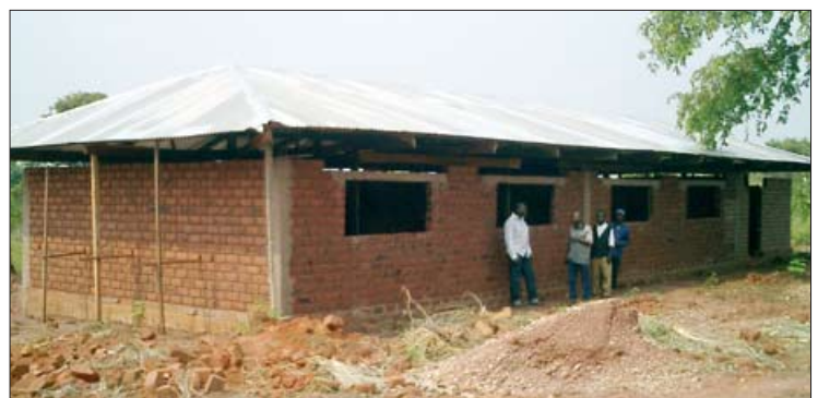
Links: Zuerst wird das Dach gefertigt zum Regenschutz beim Bauen, dann kommen die Wände. Rechts: ... fast fertig!
