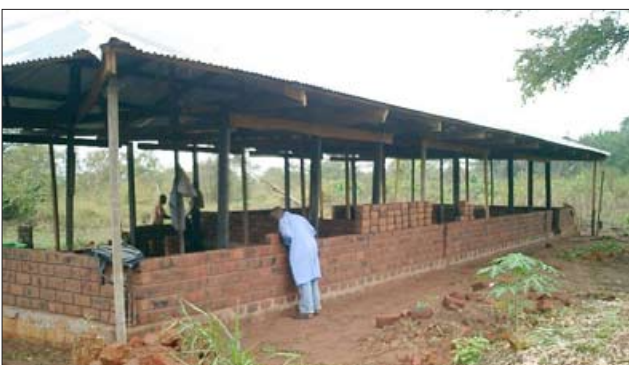
Links: Zuerst wird das Dach gefertigt zum Regenschutz beim Bauen, dann kommen die Wände. Rechts: ... fast fertig!
