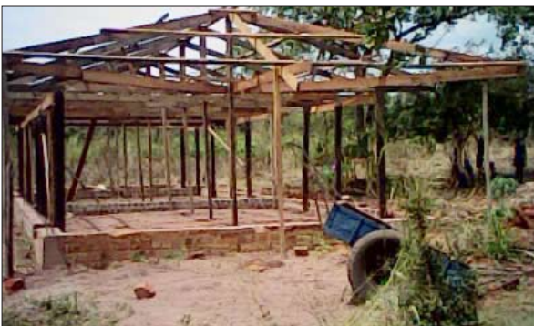
Dachgerüst von unserem zweiten Schulgebäude
