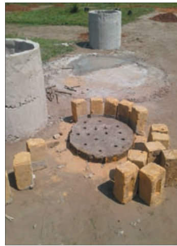
Le trou du puits est creusé. Préparer des anneaux en ciment. Filtre à eau. Mettre en place les murs en ciment dans le puits.
